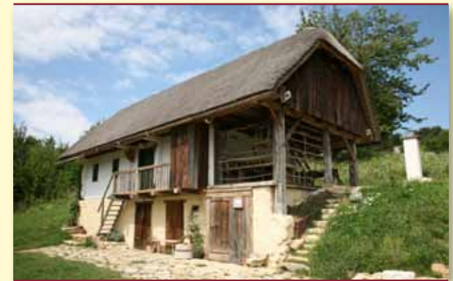
Obnovljena kozjanska domačija v Ravnem A restored Kozjansko homestead in Ravno
